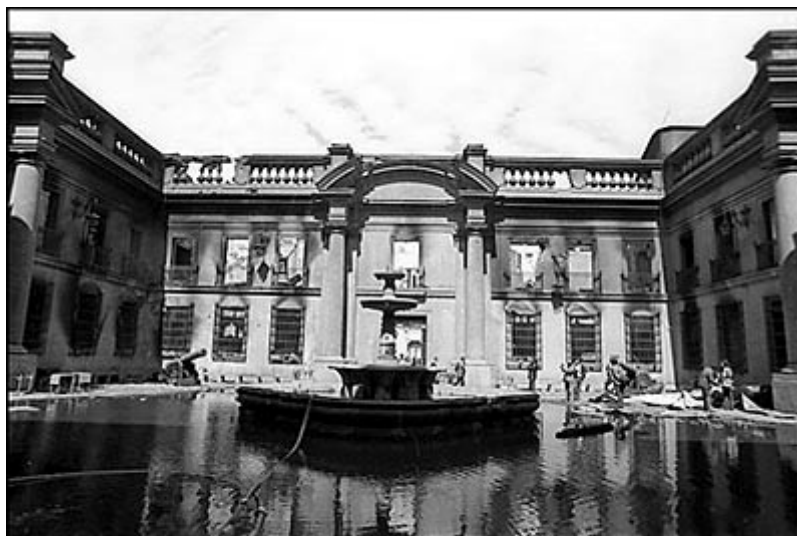
El patio de la fuente, como mucho del palacio, muestra las huellas del feroz bombardeo.
