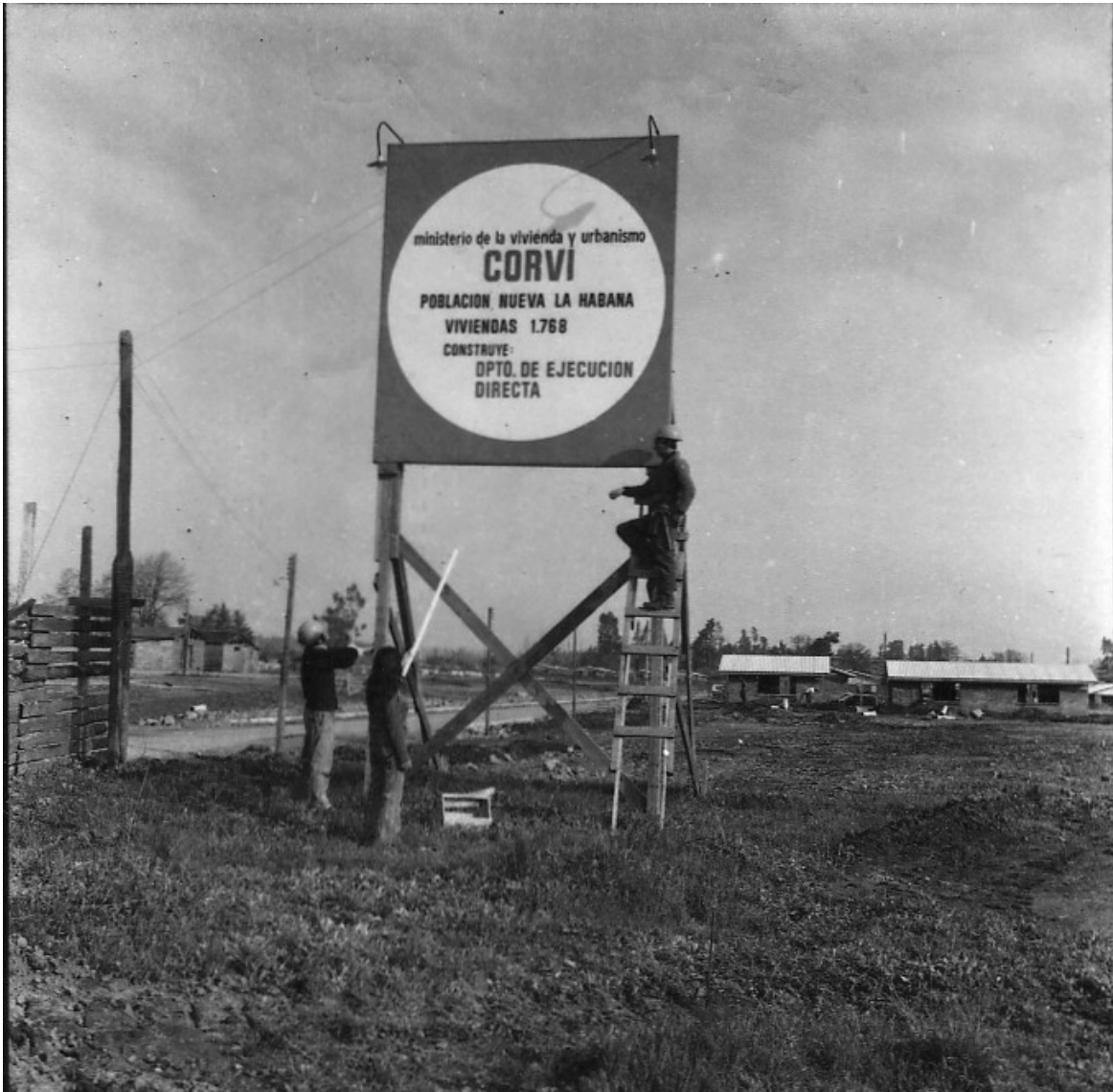
Entrada a la obra “población Nueva La Habana”, Santiago, 1971.
