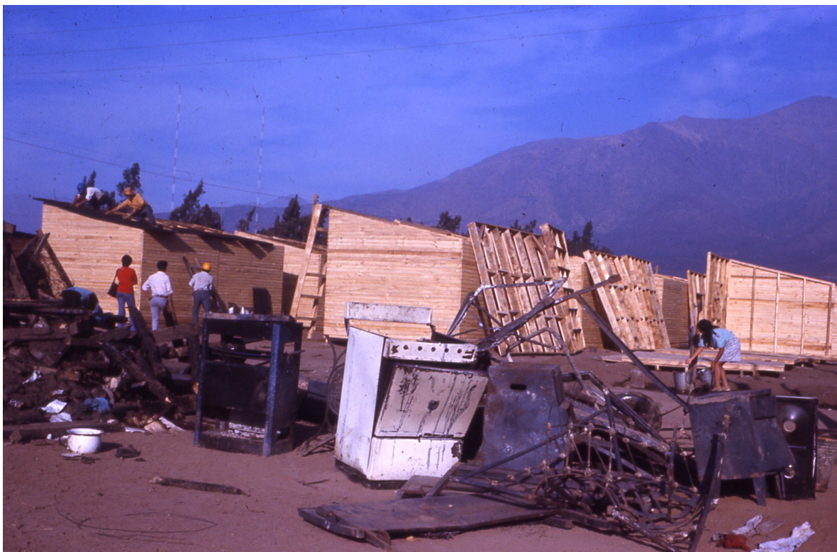
Restos del incendio y construcción de nuevas mediaguas para pobladores, Nueva La Habana, 1972.
