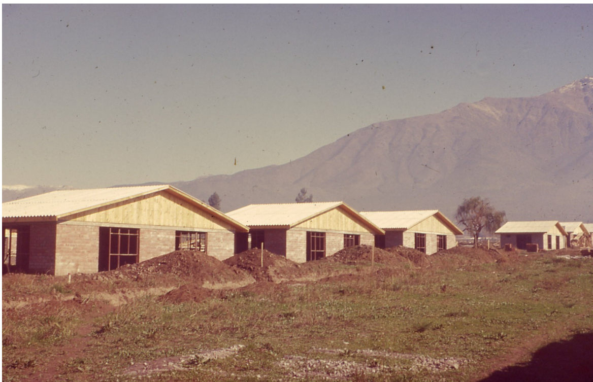
Casas C36 en construcción, Nueva La Habana, Santiago, 1972.
