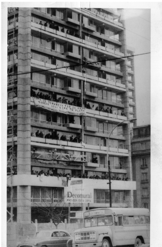
Toma de las Torres de Remodelación San Borja. Santiago, 17 de agosto de 1970
