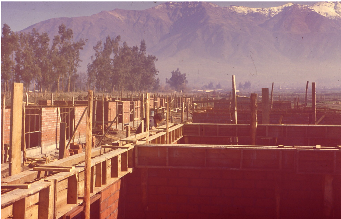
Construcción de viviendas en Obra “Población Nueva La Habana”, Santiago, 1971.
