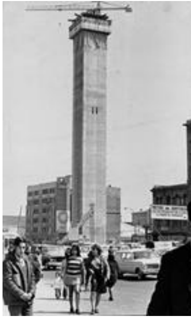
Foto de la torre ENTEL en plena construcción, a principios de los 70
